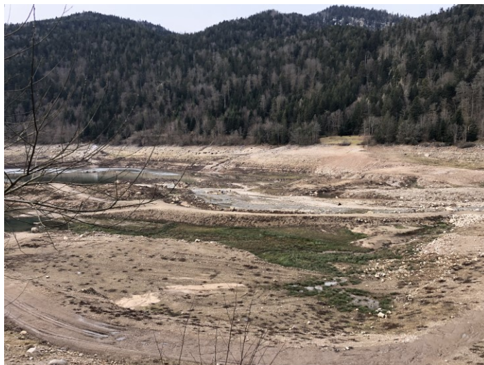
Vue du lac début 2021 en aval de la digue centrale
