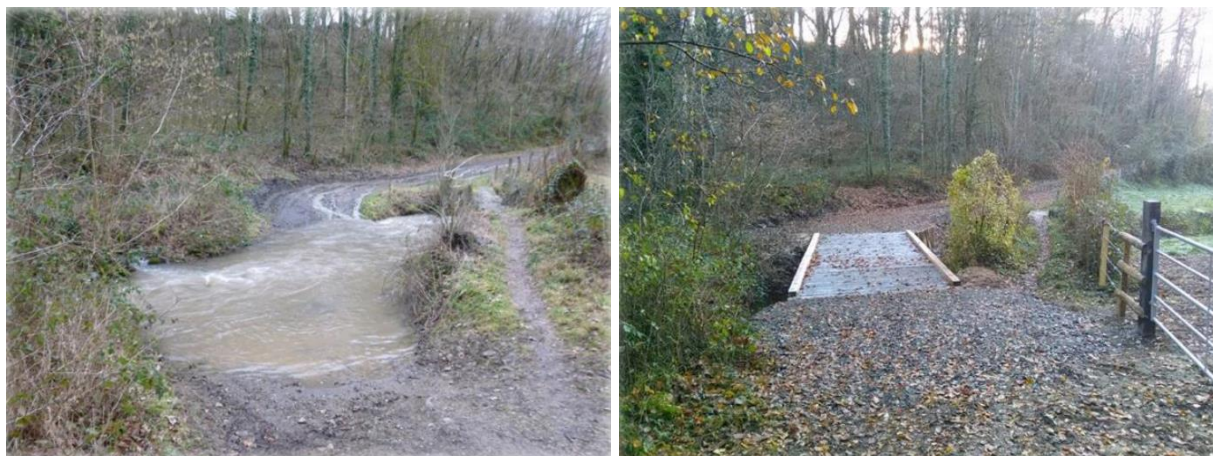
Figure 58: Exemple de passerelle engin (avant et après travaux) (Photos: ©FDAAPPMA14)
