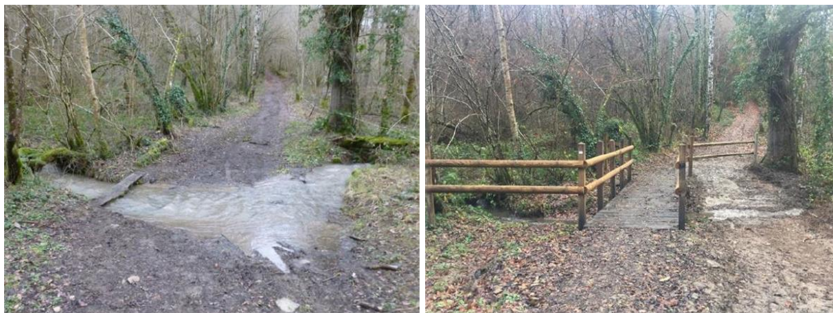
Figure 57 : Exemple de passerelle piéton (avant et après travaux) (Photos: ©FDAAPPMA14)
