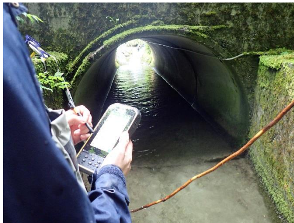
Figure 20: Photographie du GPS de terrain lors de la saisie d'un obstacle
