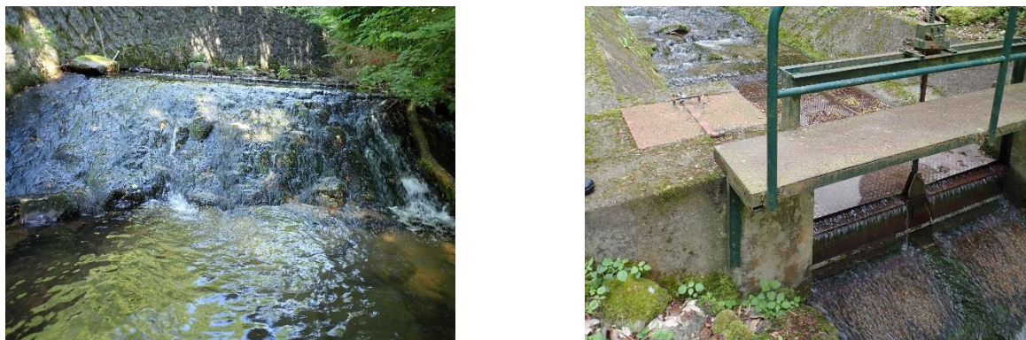
Figure 48: Photographies d'ouvrages infranchissables dont une station de captage à droite
