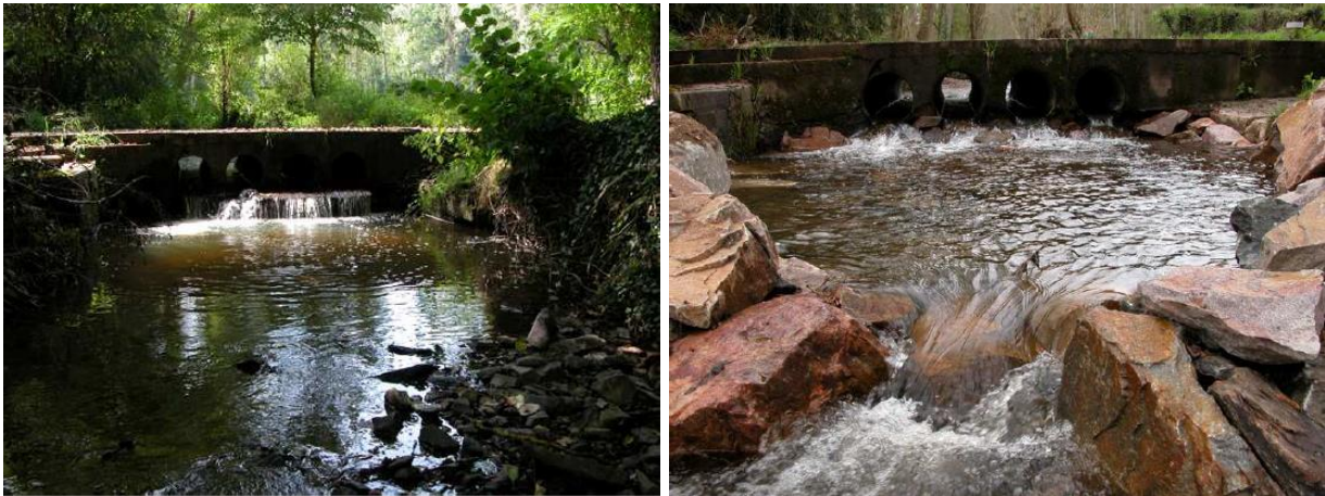
Figure 53: Exemples de seuils bois, béton et enrochement (photos avant et après travaux) (©FDAAPPMA36)
