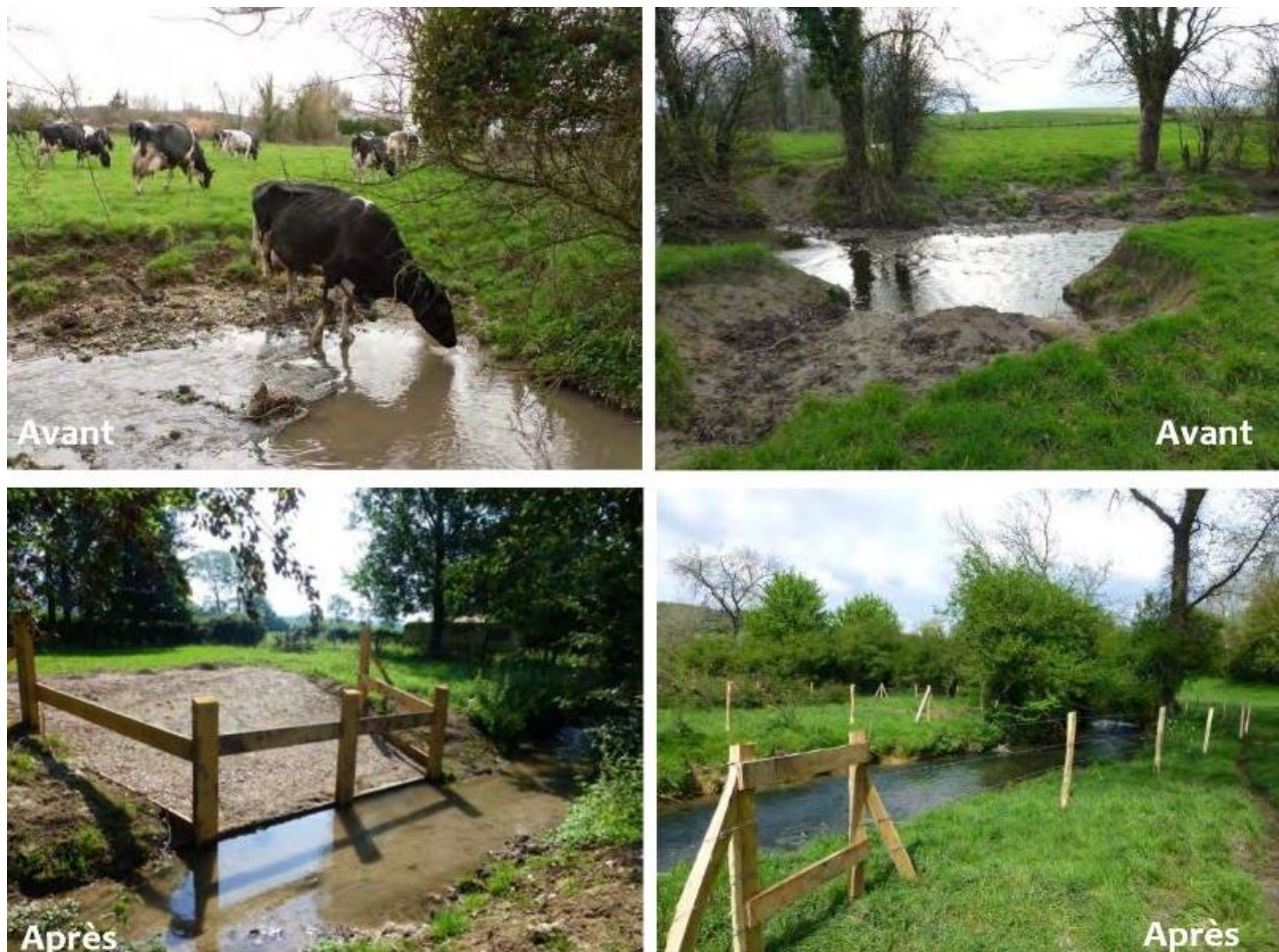
Figure 59: Exemple d'aménagement pour limiter le passage du bétail au sein du cours d'eau (Photos : ©FDAAPPMA62)
