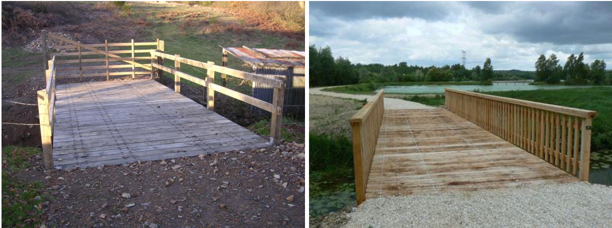
Figure 52: Exemple de passerelle bois engins (Photos : ©FDAAPPMA61 et Marcanterra)
