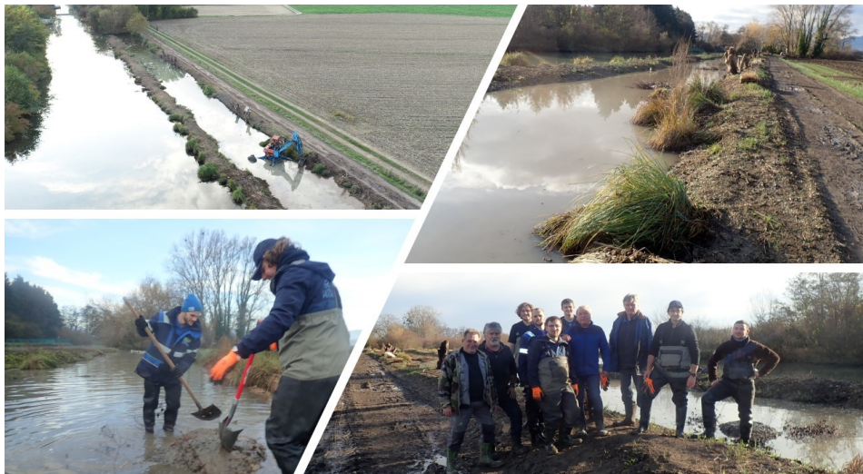
Illustrations des travaux sur la frayère du canal de Colmar.
