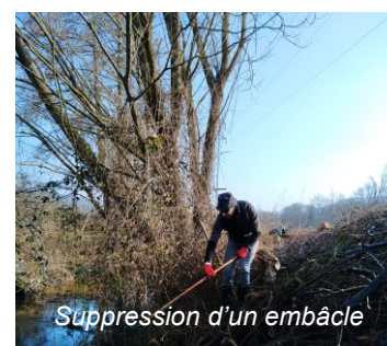
Chantier nature - frayère du canal de Colmar
