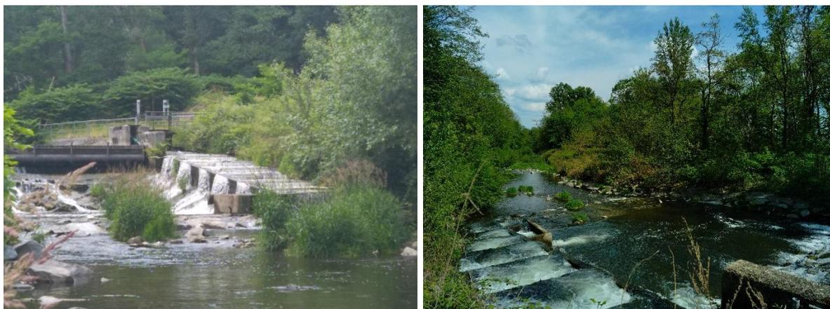
Figure 5 : Illustration de l'ouvrage ROE 1702 de prise d'eau le 29 juin 2022 à gauche et le 28 octobre 2022 à droite. On observe que la passe à poissons en rive gauche est infranchissable lié à de probables problèmes de manœuvre (ici débordement).
